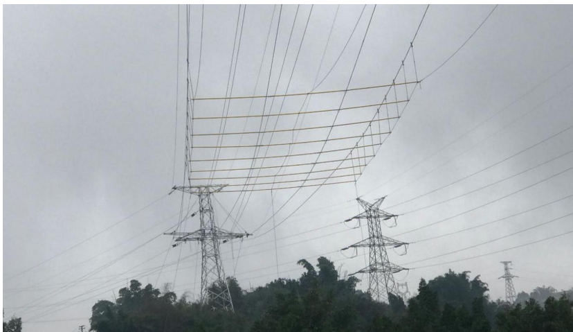
图 1-1: 封顶网放线
