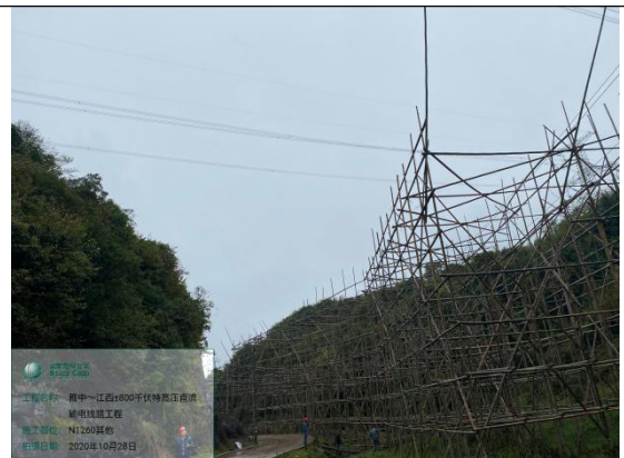
跨越施工场地
