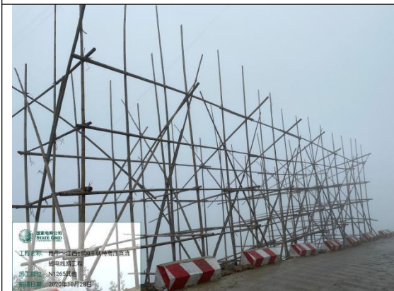
跨越施工场地
