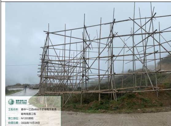
跨越施工场地
