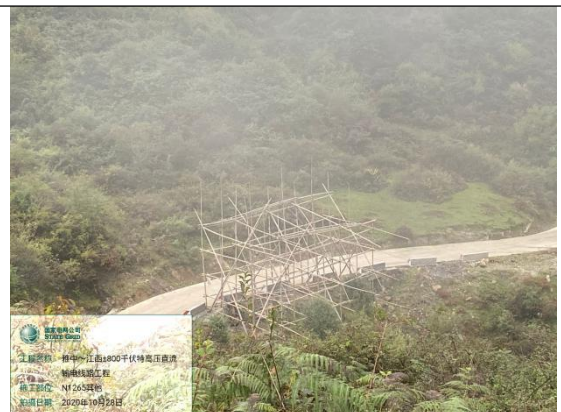
跨越施工场地
