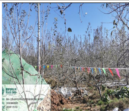
N55 临时堆土防尘网苫盖+施工场地彩旗绳限界
