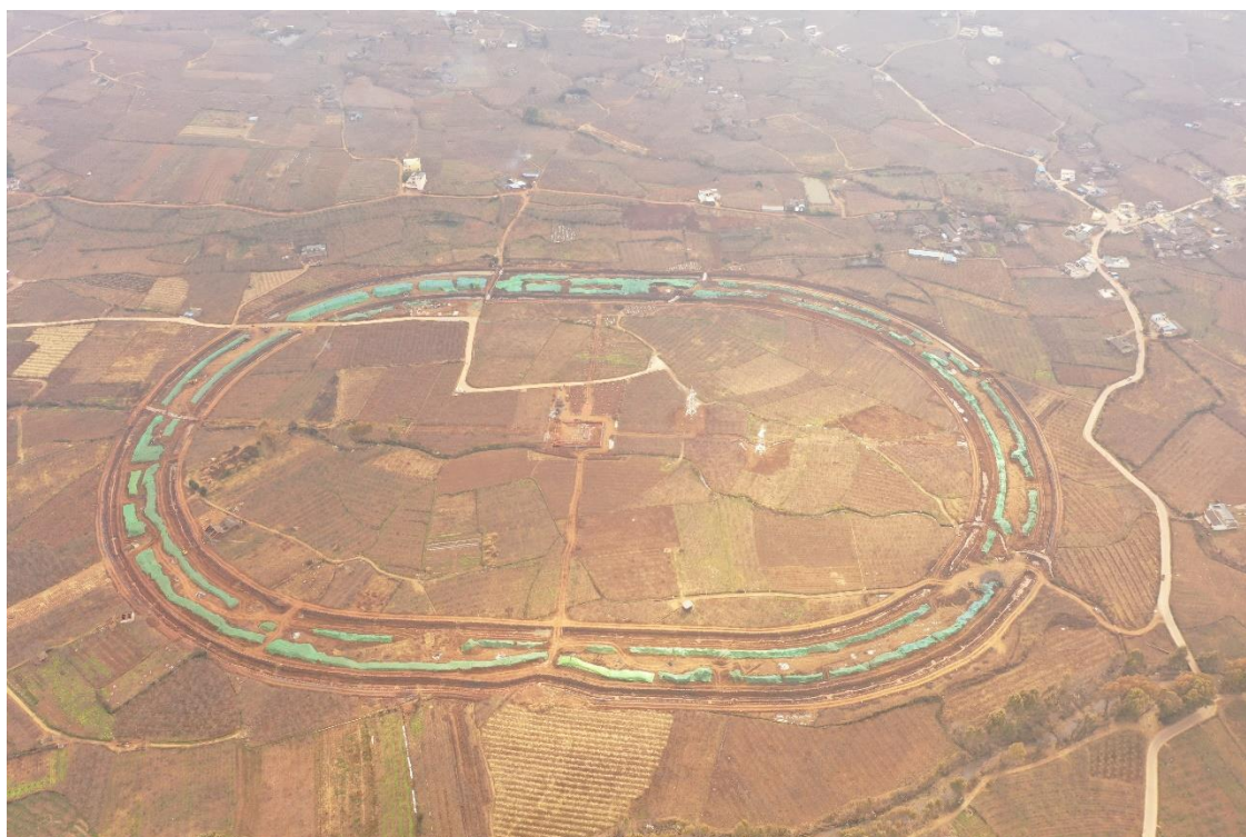
送端接地极施工扰动区无人机照片
