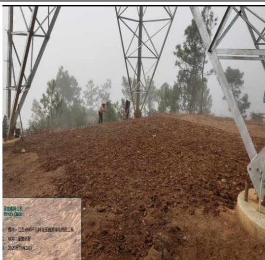
N0011 塔基区土地平整及草籽撒播
