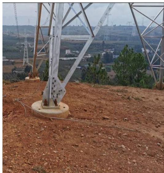
N0012 塔基区土地平整
