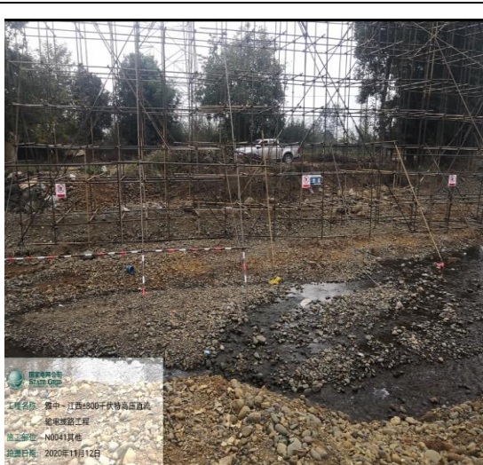
N0041 施工跨越场地
