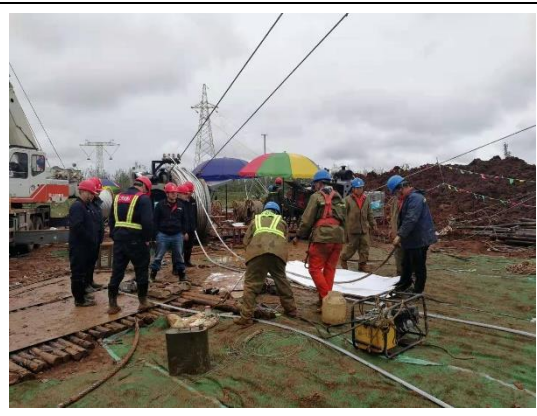
N40 牵张场钢板铺垫+防尘网苫盖
