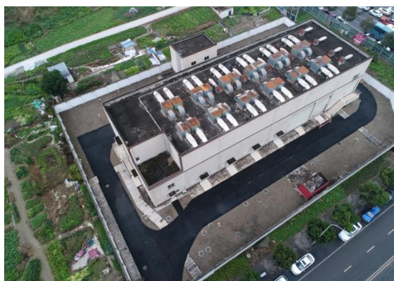
变电站全景图 1
