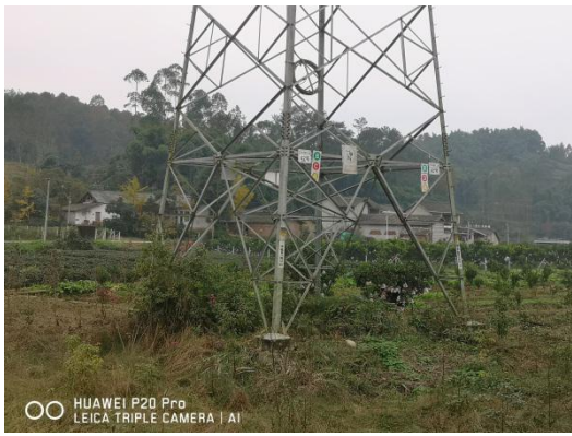
塔基现状-绿化 (42#)
