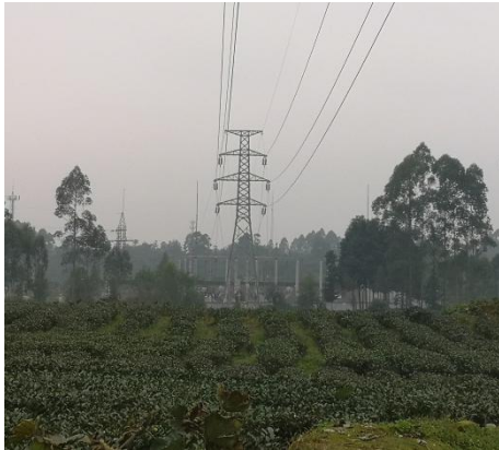
塔基现状-复耕 (44#)
