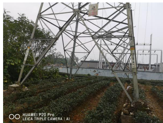
塔基现状-复耕 (47#)
