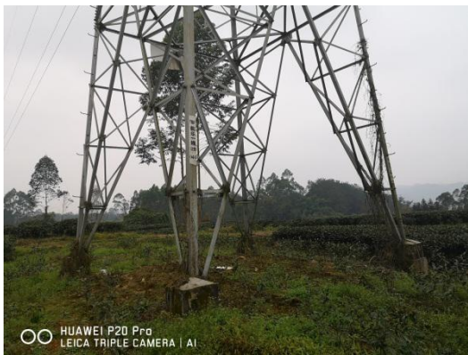
塔基现状-复耕 (46#)
