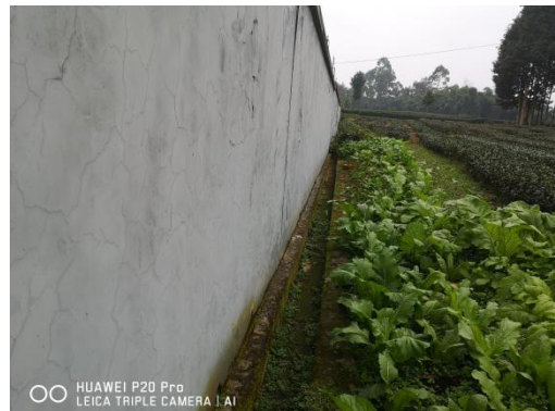
站外排水沟和复耕 (2020 年 12 月摄)
