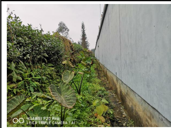
站外排水沟和复耕（2020 年 12 月摄）
