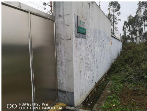
平乐 110kV 变电站 (2020 年 12 月摄)
