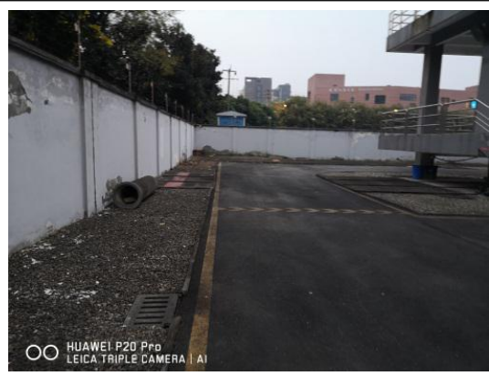
站内雨水系统和碎石铺设
