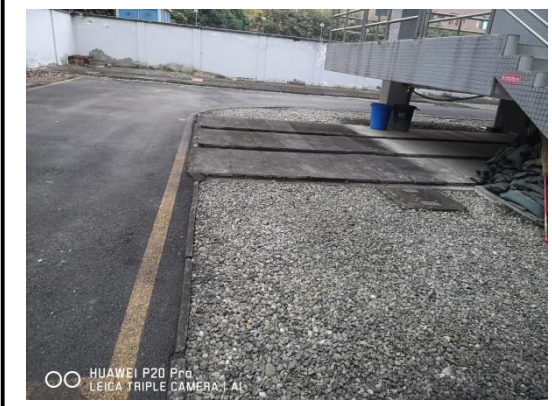
站内碎石铺设
