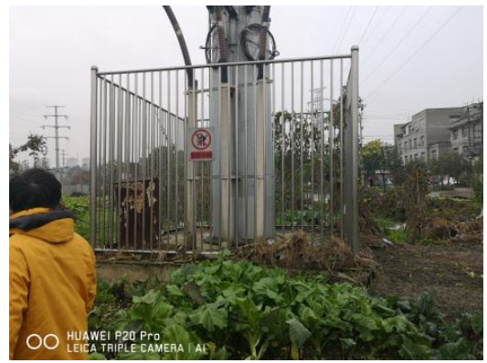
终端塔电缆下地
