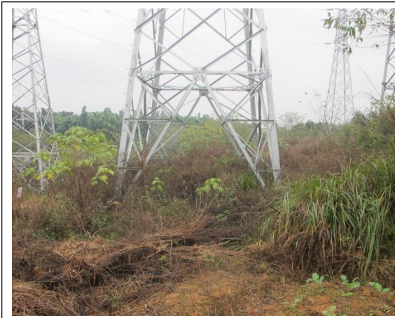
17 号塔植被恢复情况
