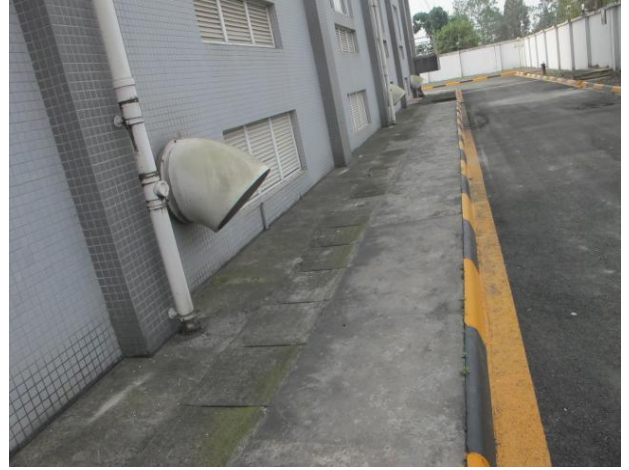
站内排水沟及道路
