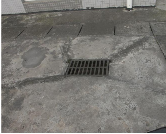
站内排水沟及雨水口
