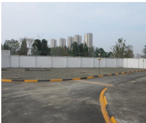
站内碎石压盖场地 1
