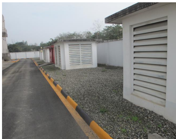
站内碎石压盖场地 2
