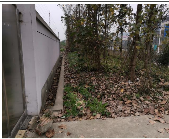
站外排水沟及植被绿化
