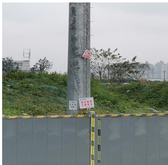
36 号塔植被恢复情况
