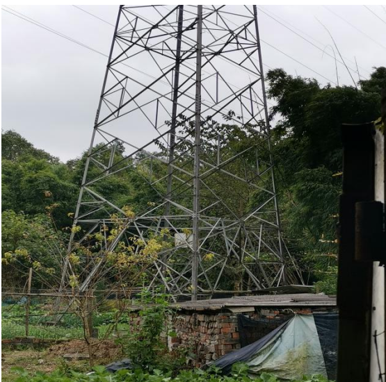
55 号塔植被恢复情况
