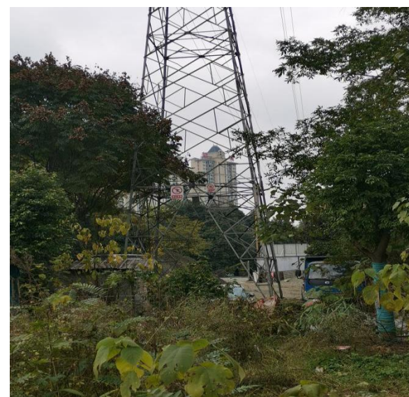
50 号塔植被恢复情况
