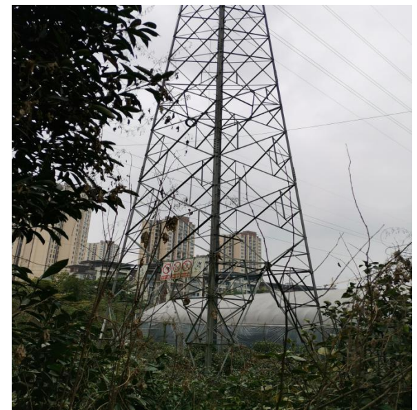
54 号塔植被恢复情况
