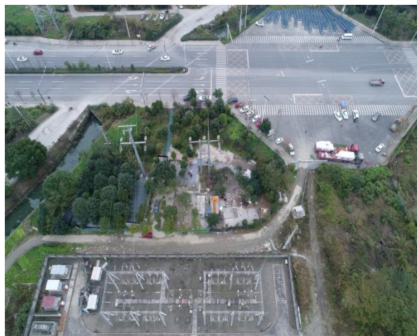
T接线路铁塔植被恢复情况
