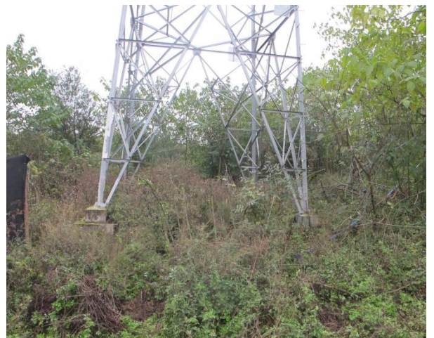
11 号塔植被恢复情况
