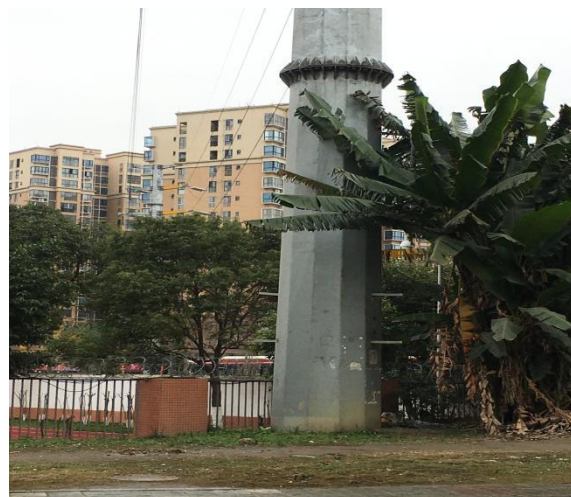
21 号塔植被恢复情况
