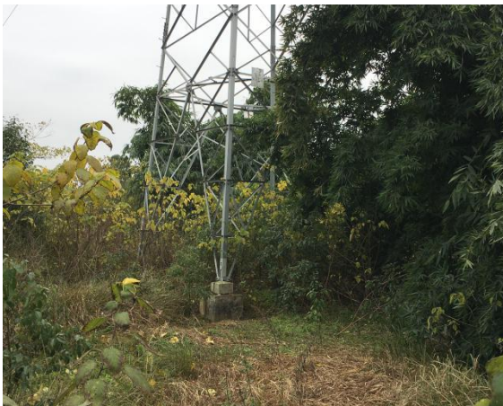
10 号塔植被恢复情况
