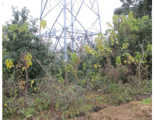
14 号塔植被恢复情况
