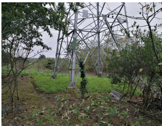
8 号塔复耕及植被恢复情况
