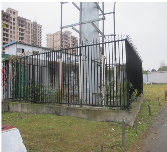
站外终端塔现状
