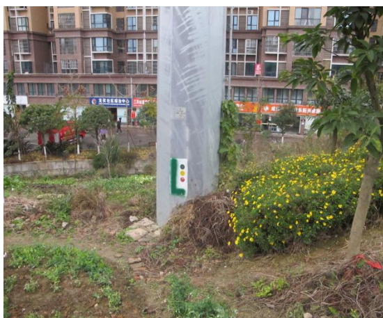
17 号塔植被恢复情况
