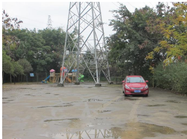
3 号塔区域硬化情况
