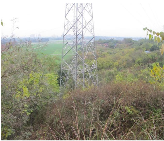
12 号塔植被恢复情况
