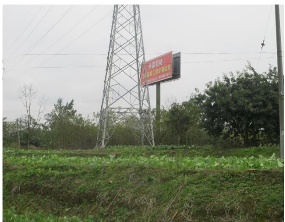
6 号塔复耕及植被恢复情况
