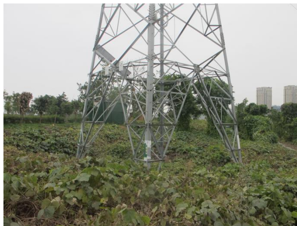
16 号塔植被恢复情况
