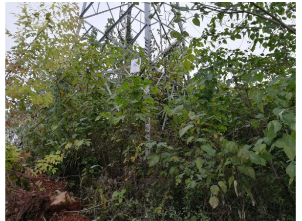
9 号塔植被恢复情况
