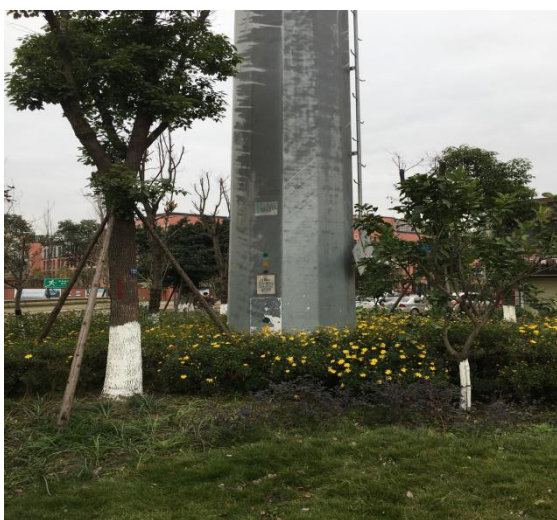
19 号塔植被恢复情况
