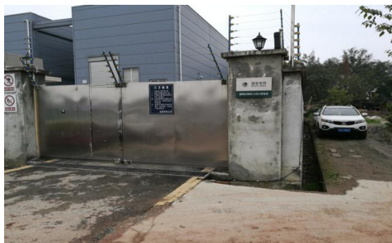
永宁 110kV 变电站
