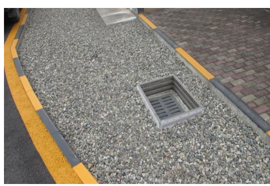
站内碎石压盖
