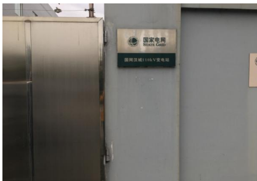
汉城 110kV 变电站
