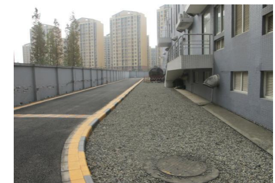
站内碎石压盖场地及雨水口 2
