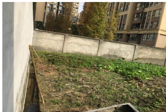
站外排水沟及撒草绿化
