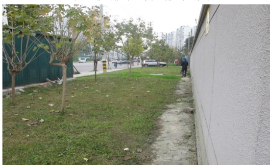
站外盖板排水沟及撒草绿化 3
