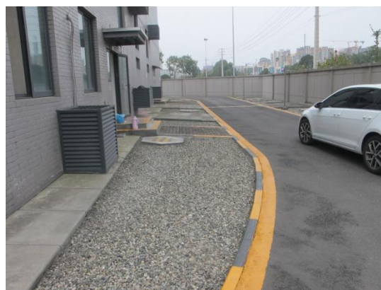
站内碎石压盖场地 2
