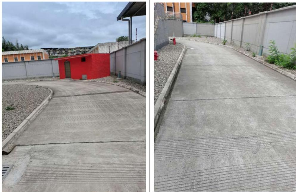
图 8-6 变电站生态保护措施情况（地面硬化）
