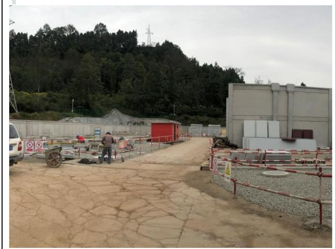
西龛变电站施工期硬化了站内道路
