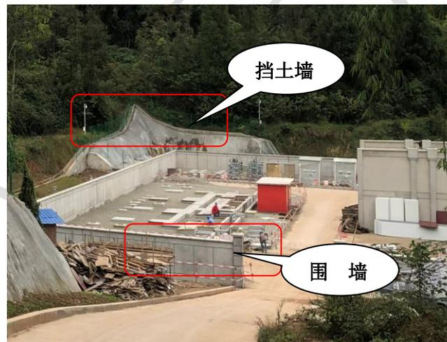
西龛变电站施工期修建了围墙及挡土墙
