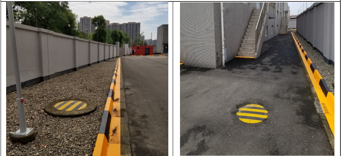
雨水沟及检查井
