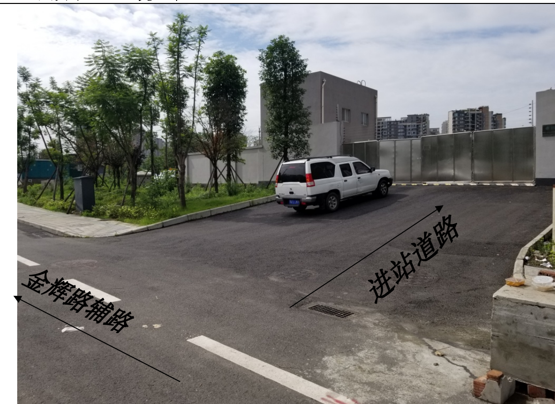
变电站进站道路
