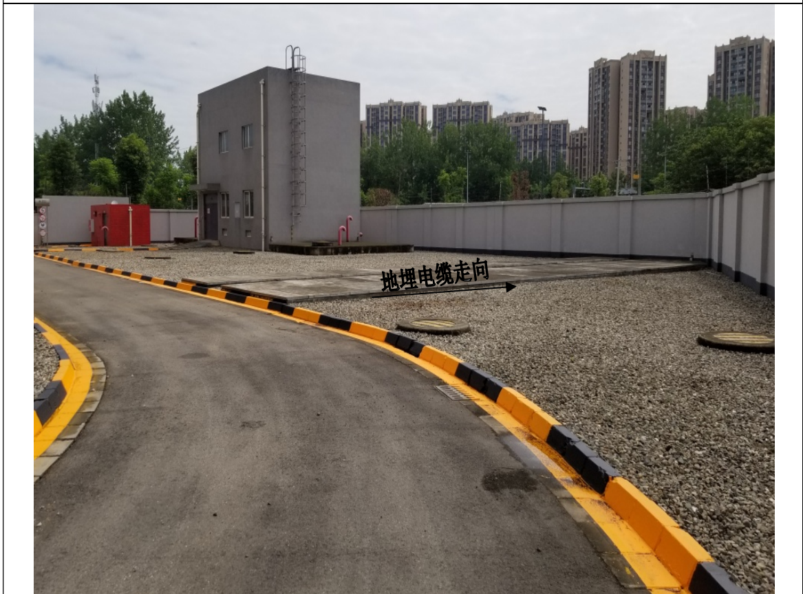
站内碎石敷设、道路硬化（1）
