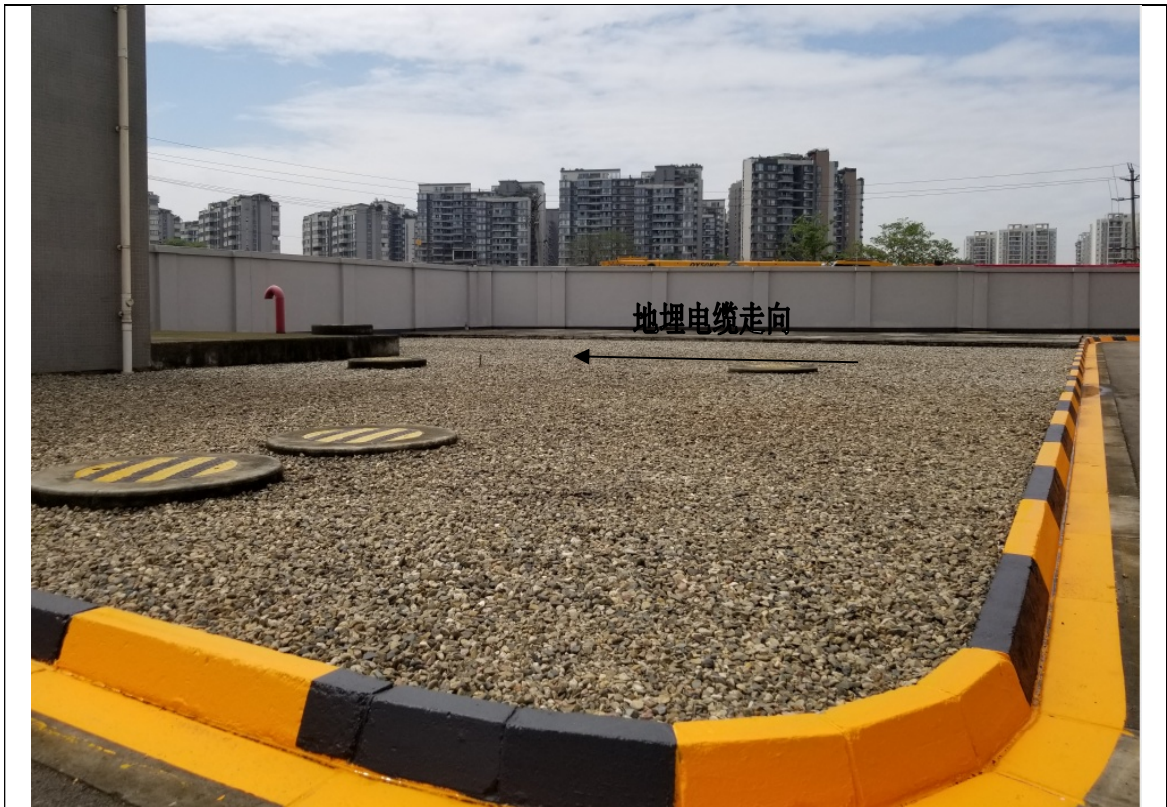
站内碎石敷设
