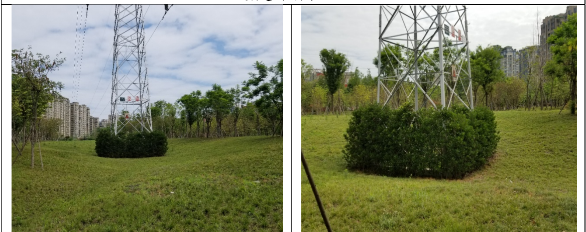
新建终端塔-N6
