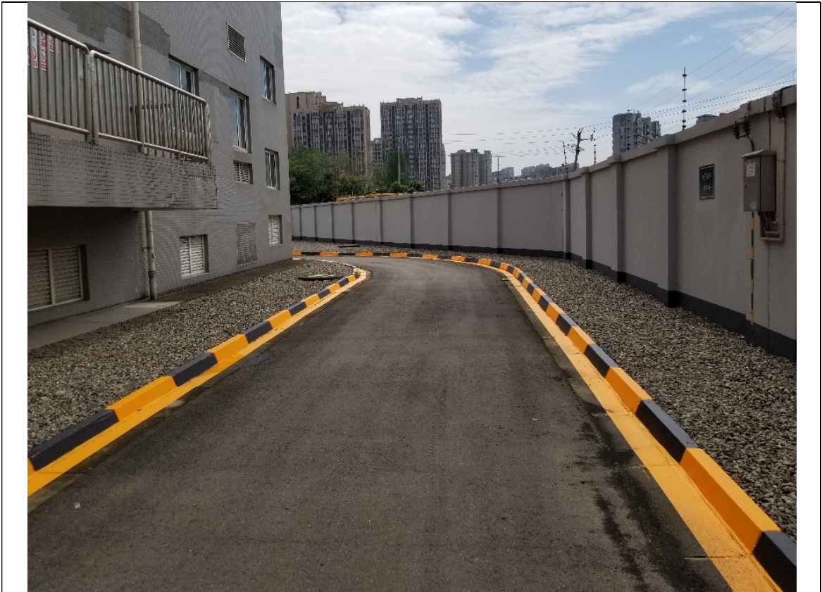
变电站站内碎石敷设、道路硬化（2）
