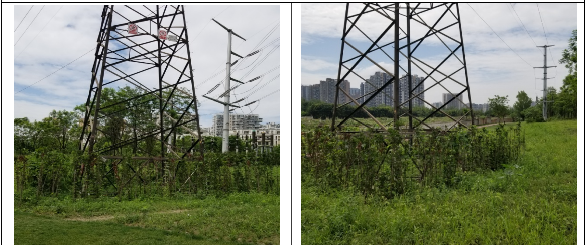
新建终端塔-N1
