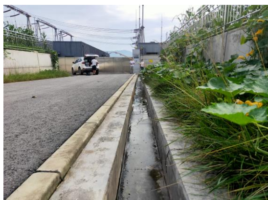
进站道路排水沟
