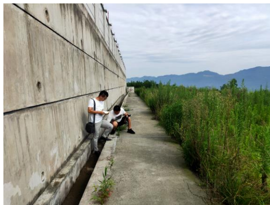
变电站区现场监测 2
