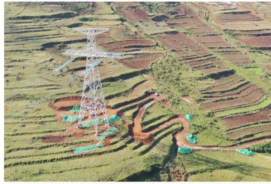
N0500 塔基区及施工道路区临时堆土防尘网苫盖
