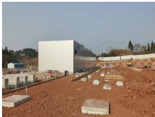
主变基础施工
