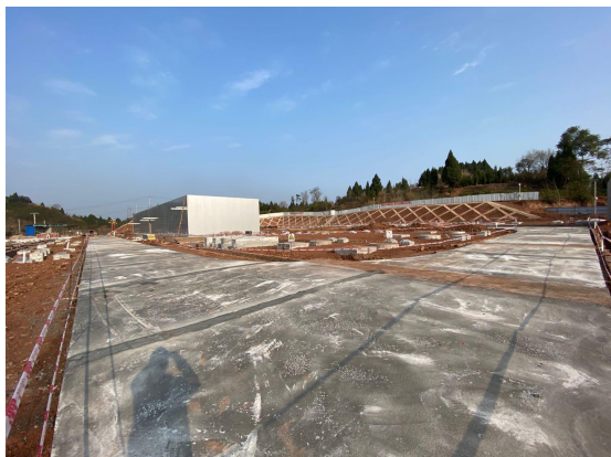
变电站站区内主道路硬化
