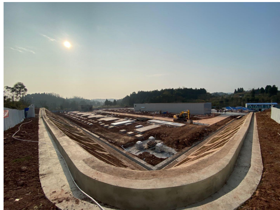
站外截水沟及边坡框格（混凝土）
