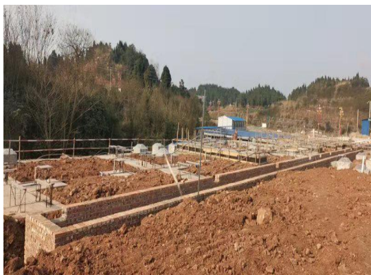
变电站站区内电缆沟砌筑、设备基础开挖
