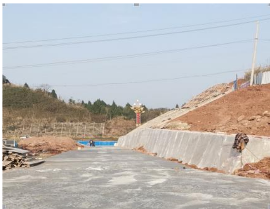
进站道路路面硬化及边坡施工（混凝土框格）
