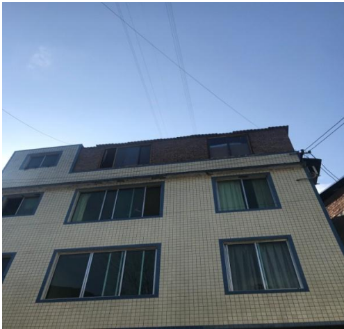
庙劳线 9 # ~10 # 塔间跨越点
