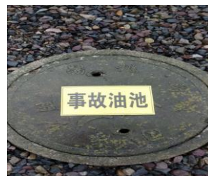
新建事故油池
