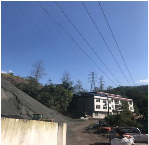
庙劳线 21 # ~22 # 塔间跨越点
