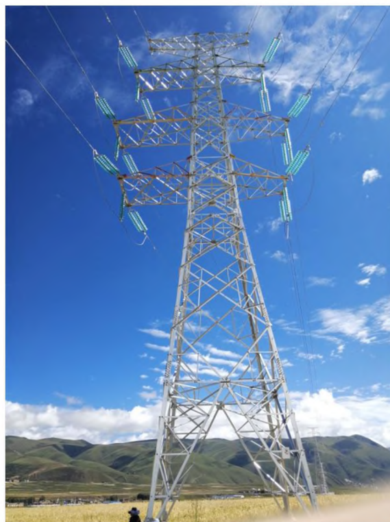
双回路来石线 3# (甘来线 98#) 塔
