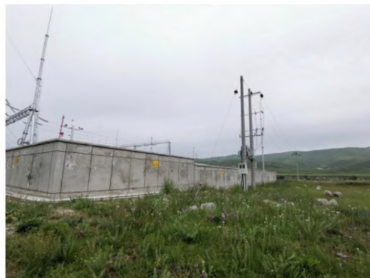
来马 110kV 变电站东侧现状
