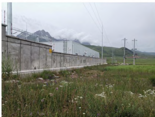
来马 110kV 变电站北侧现状
