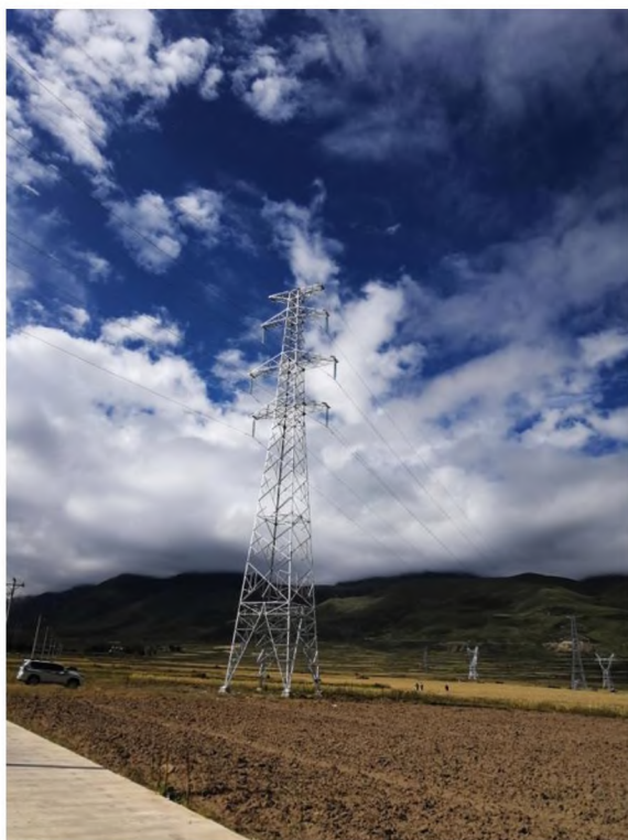
双回路来石线 2# (甘来线 99#) 塔
