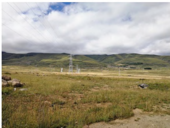
工程输电线路现状
