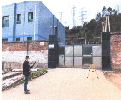
图 2-1 变电站南侧大门处
