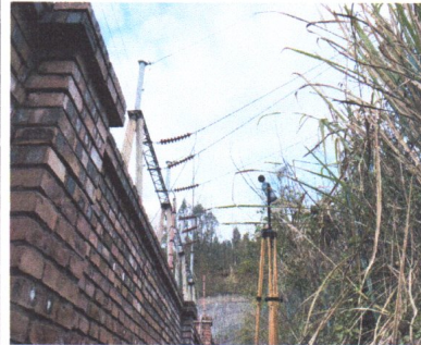
图 2-2 变电站东侧厂界处
