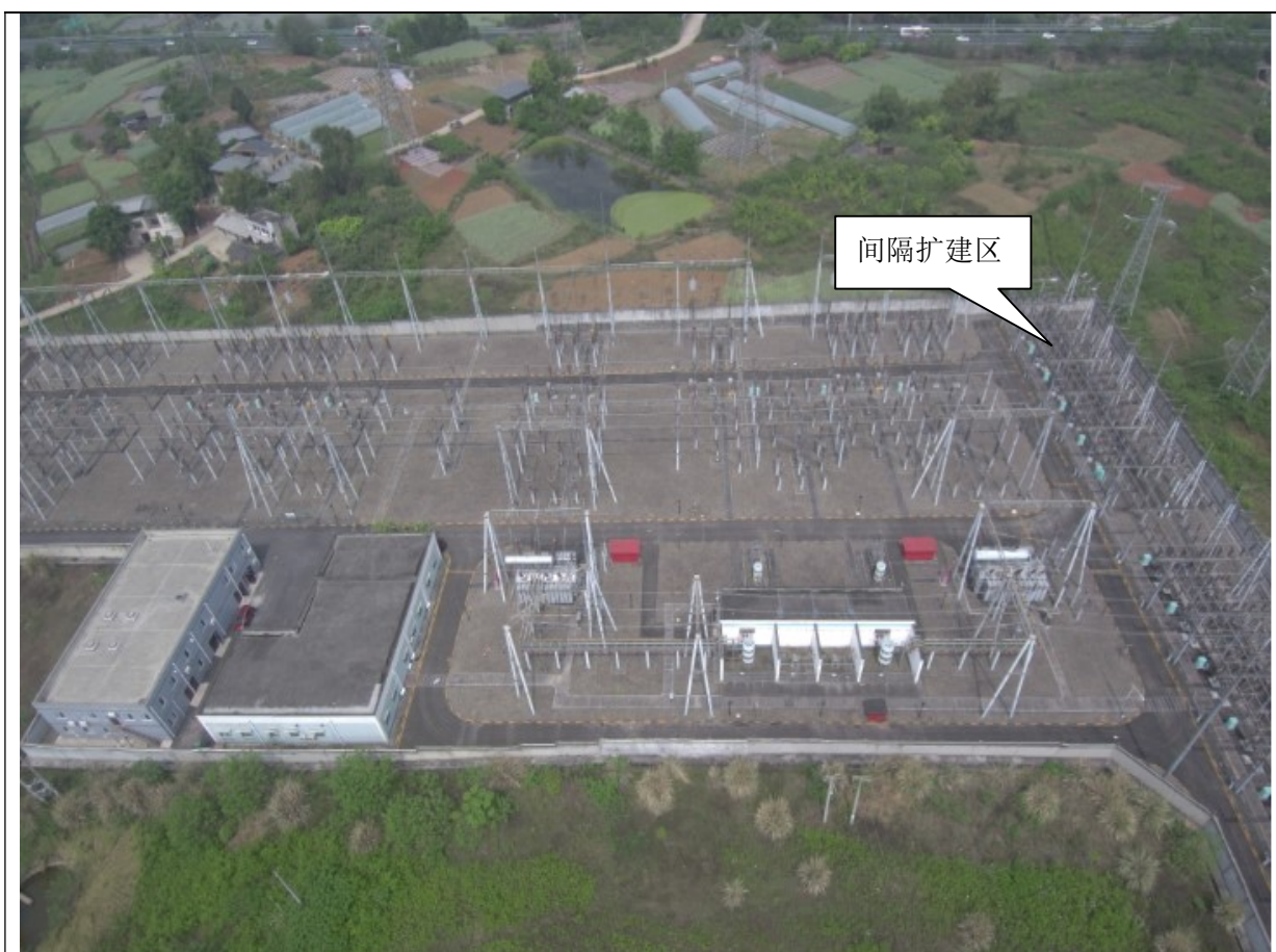
云绣 220kV 变电站航拍全景间隔扩建工程
