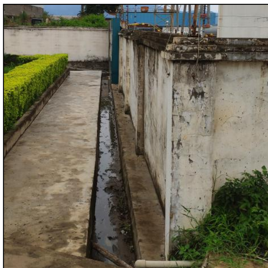
图 8-2 本项目变电站站外绿化恢复及排水沟情况
