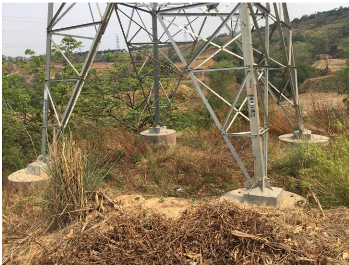
塔基下方植被恢复（禹米一、二线 2#塔）
