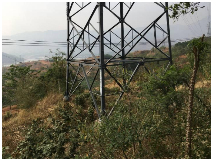
塔基下方植被恢复（禹顺一、二线 6#塔）
