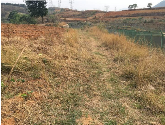
施工便道植被恢复（回龙沟变电站外）
