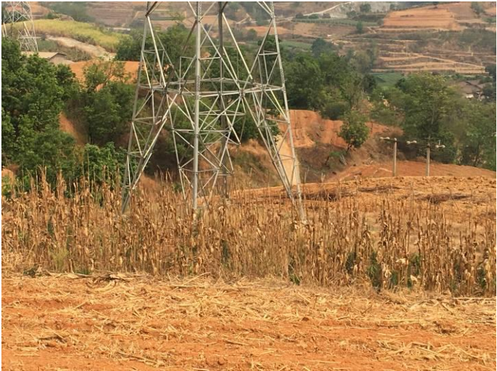
塔基下方土地复耕（禹米一线 9#塔）
