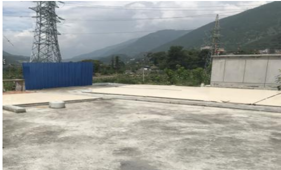
施工临时建筑拆除后
