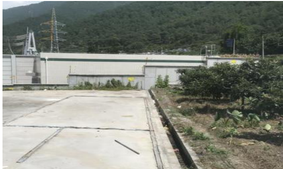
施工临时建筑拆除后
