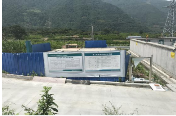
施工临时建筑拆除过程中
