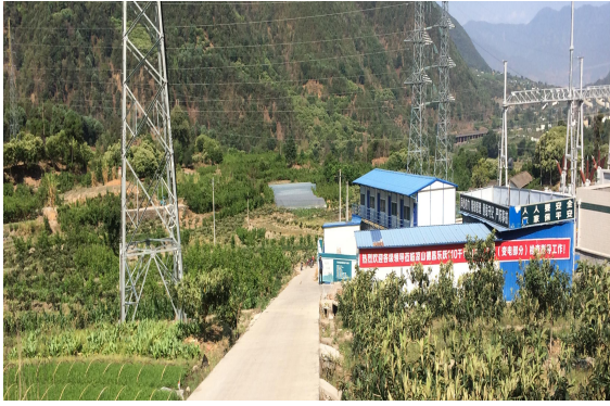
施工临时建筑未拆除前
