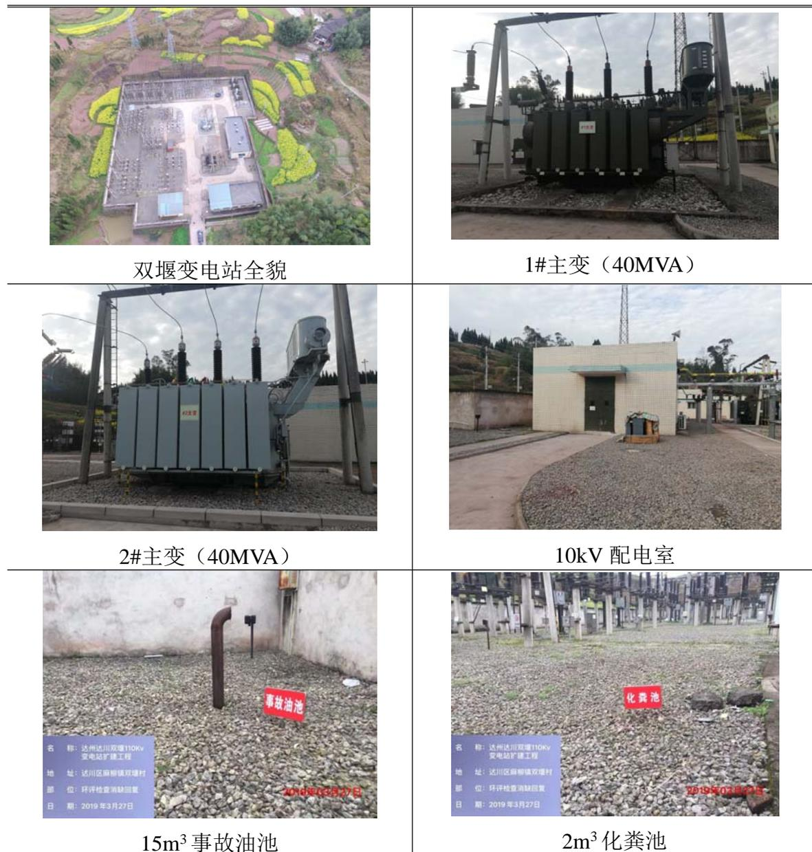
图 4-2 双堰 110kV 变电站站内设施图
