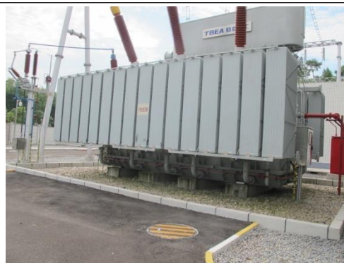
图 2 主变压器（3#）
