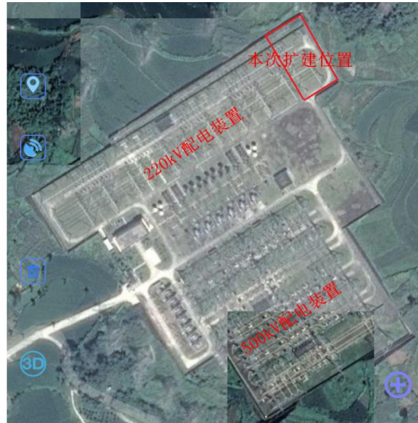
图 5 达州 500kV 变电站本次扩建位置
