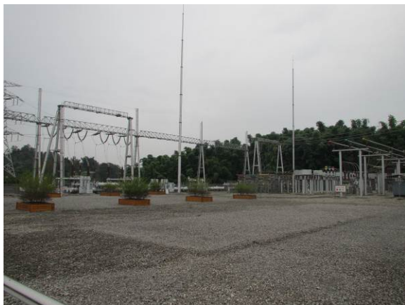
沐溪 500kV 变电站站区现状
