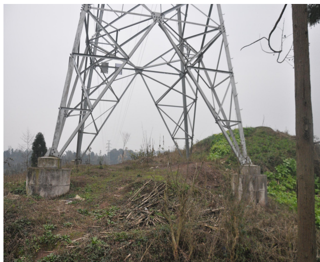
塔基及塔基临时占地现场照片
