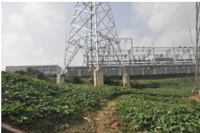
人抬道路恢复后现场照片
