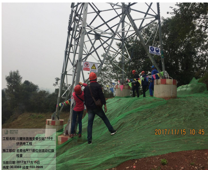
线路工程施工现场照片
