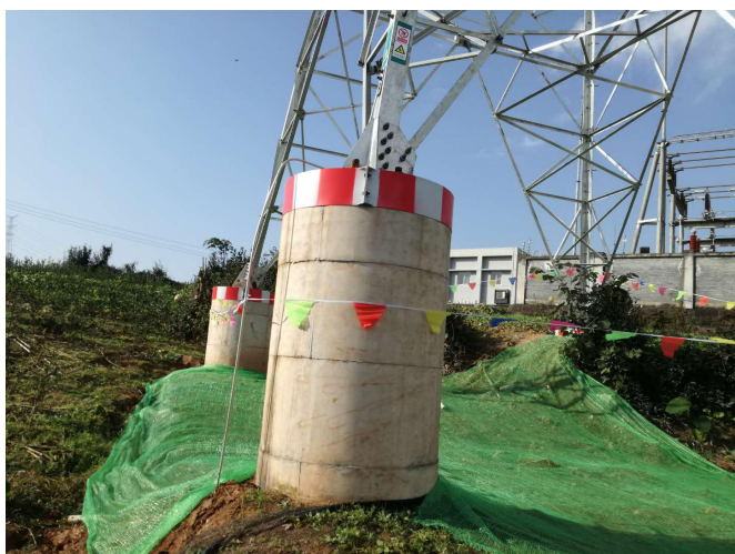
线路工程施工现场照片
