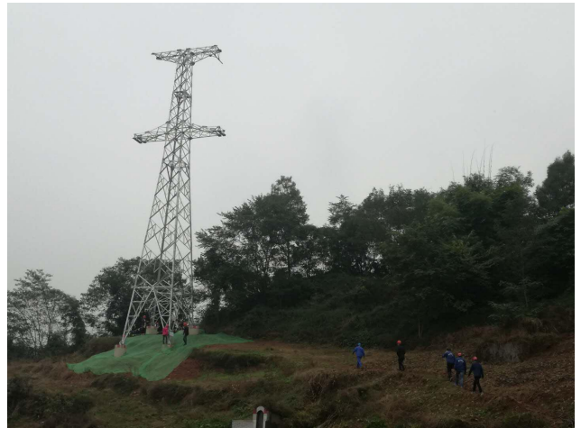
塔基区密目网遮盖
