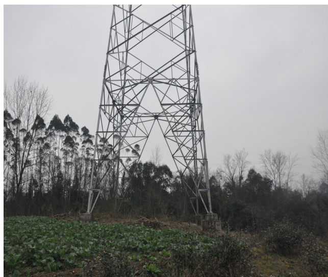
塔基及塔基临时占地现场照片
