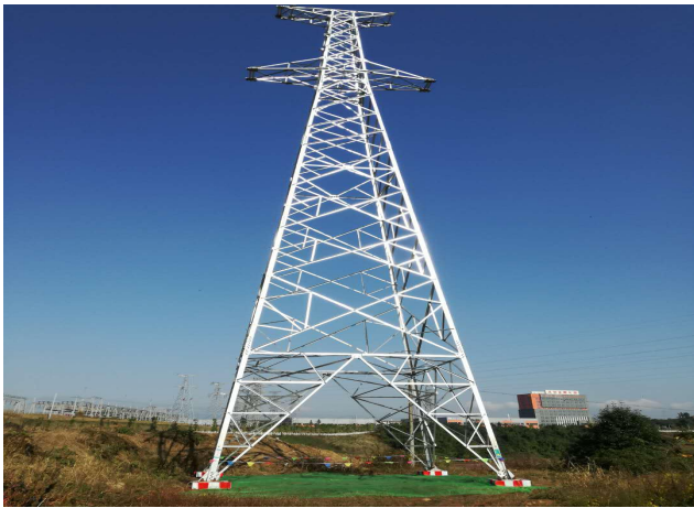
线路工程施工现场照片
