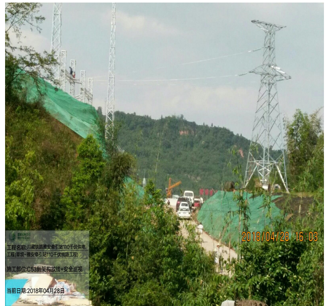
线路工程施工现场照片
