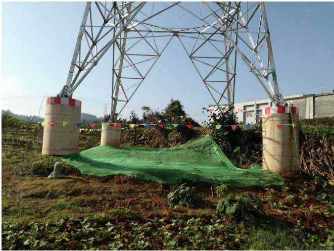
塔基区密目网遮盖
