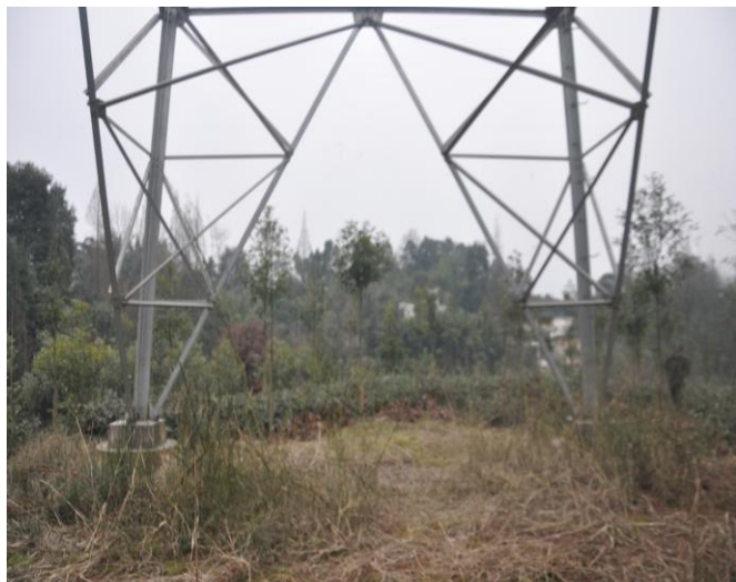
塔基及塔基临时占地现场照片
