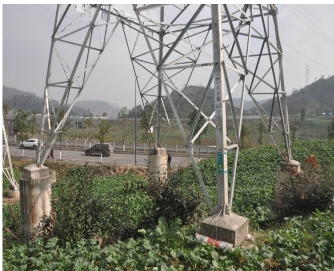
塔基及塔基临时占地现场照片
