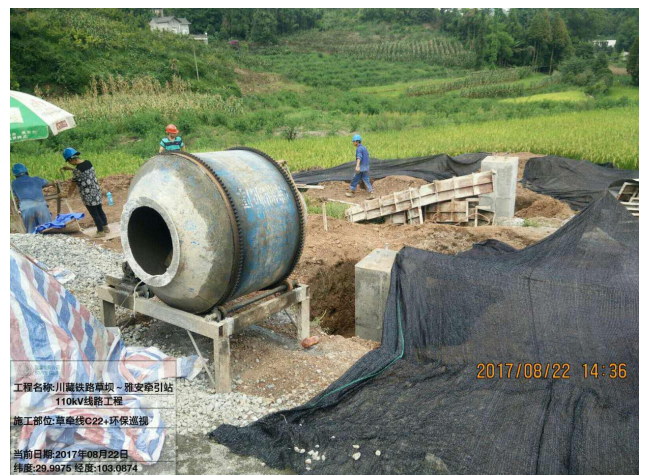
线路工程施工现场照片
