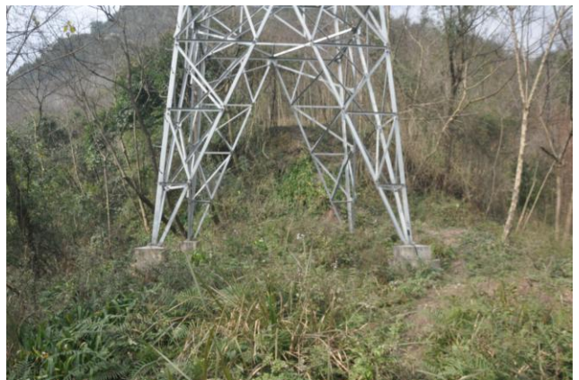
塔基及塔基临时占地现场照片
