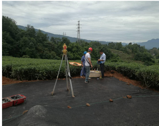
线路工程施工现场照片
