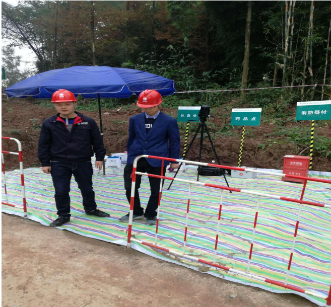
施工期防雨布遮盖
