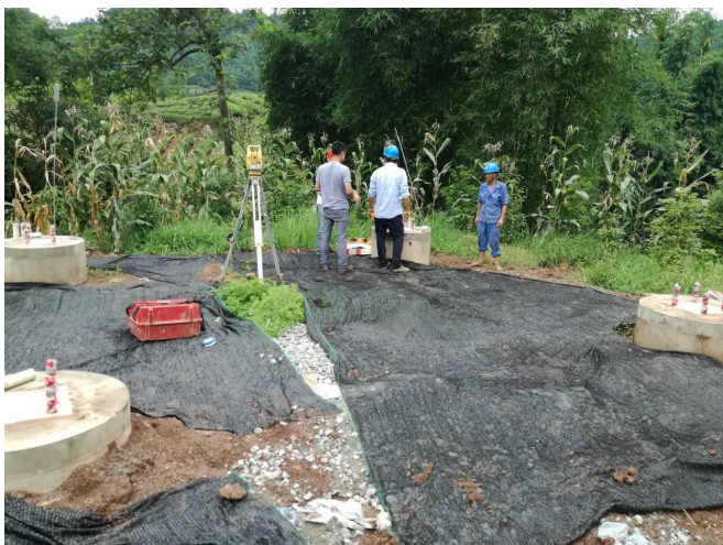
施工期密目网遮盖
