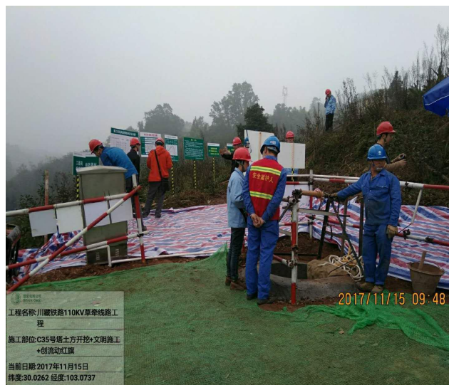
线路工程施工现场照片
