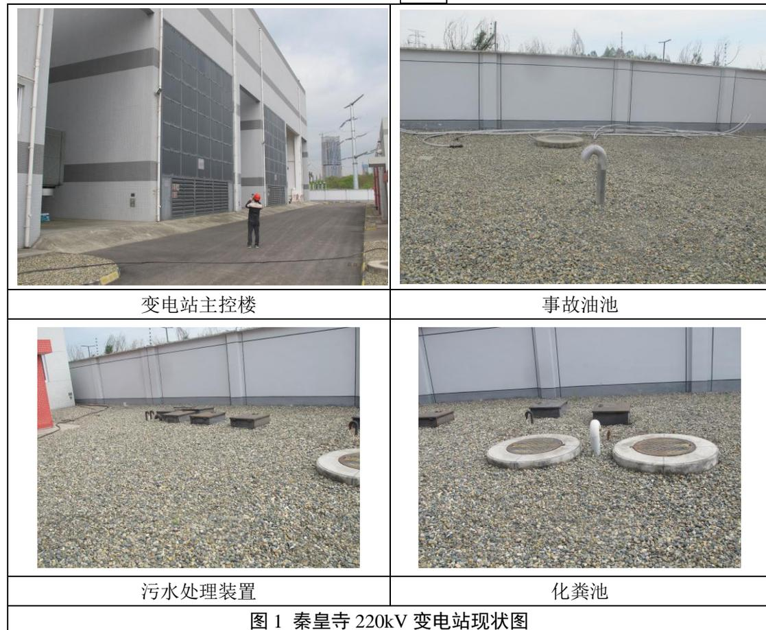
图 1 秦皇寺 220kV 变电站现状图
