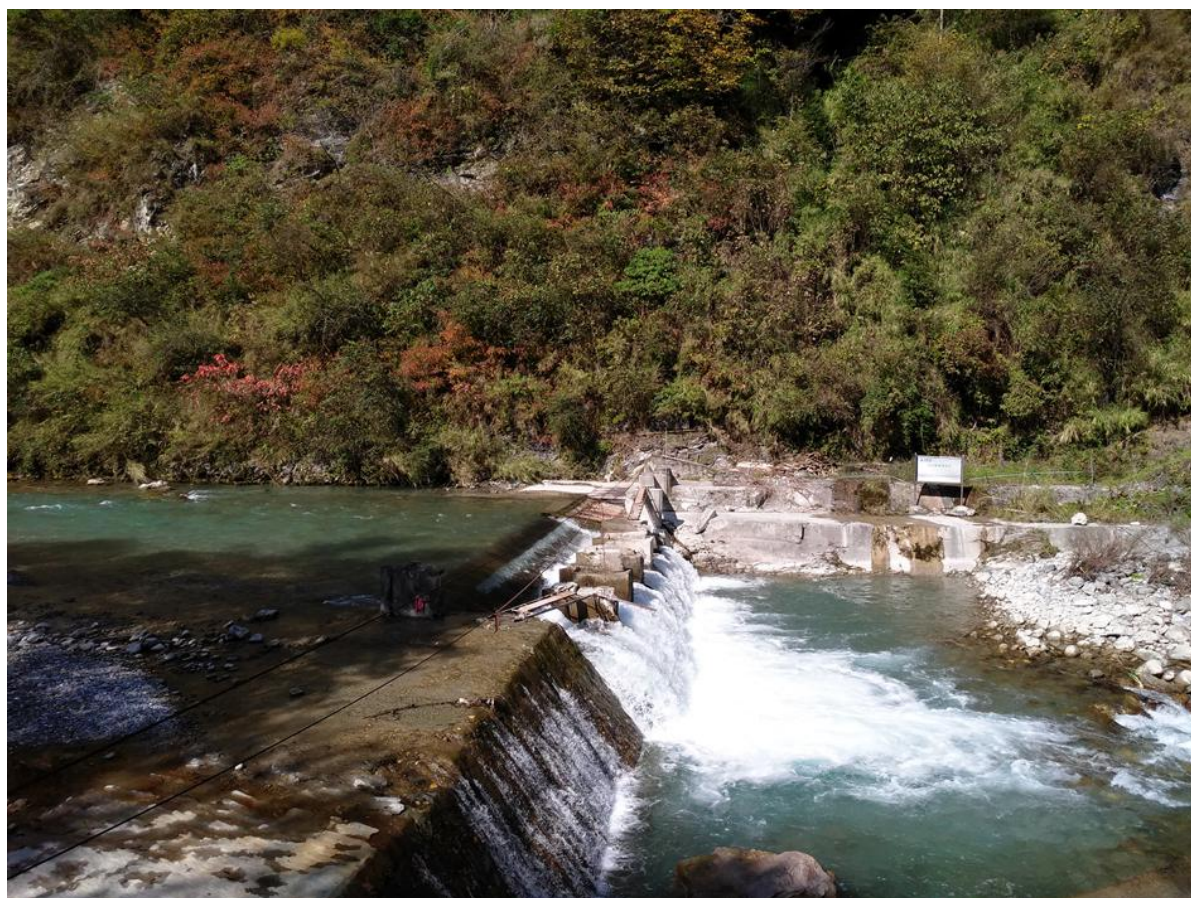
图 1-1 宝兴县赶羊沟电站挡水建筑物照片
