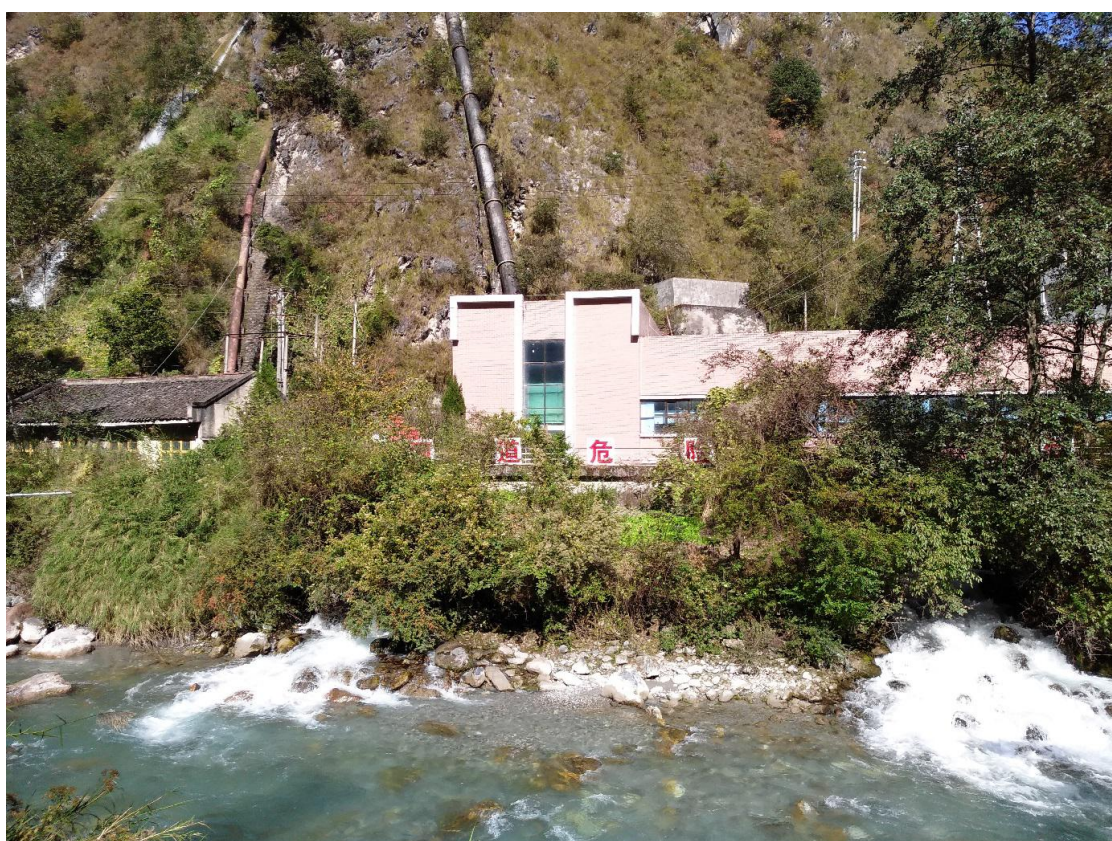
图 1-2 宝兴县赶羊沟电站尾水渠照片
